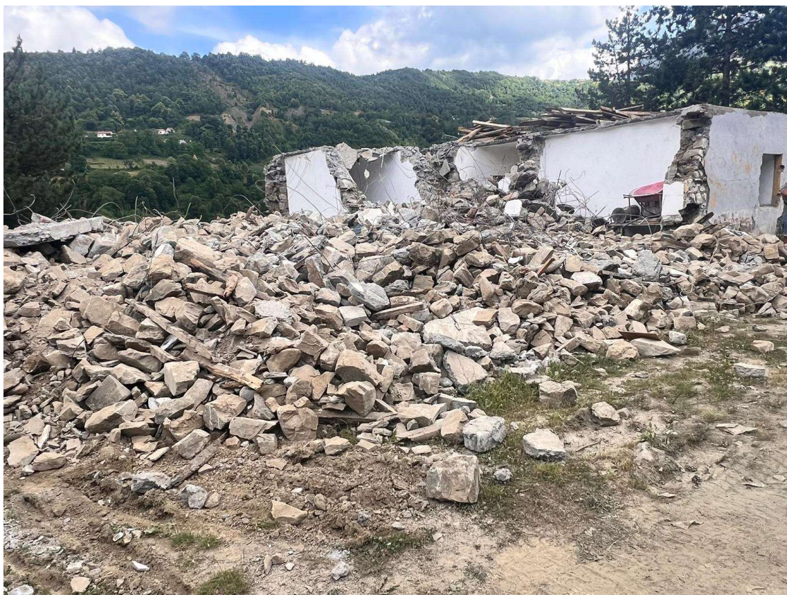
Den Abriss des alten Gebäudes übernahm die Verwaltung des Distrikts
