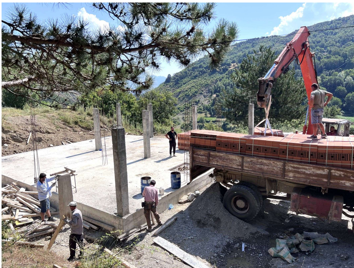
Das Fundament steht. Der Aufbau der Pfeiler ist im Gang
