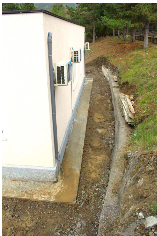
Die Stützmauer hinter dem Haus ist eine Eigenleistung der Verwaltung
