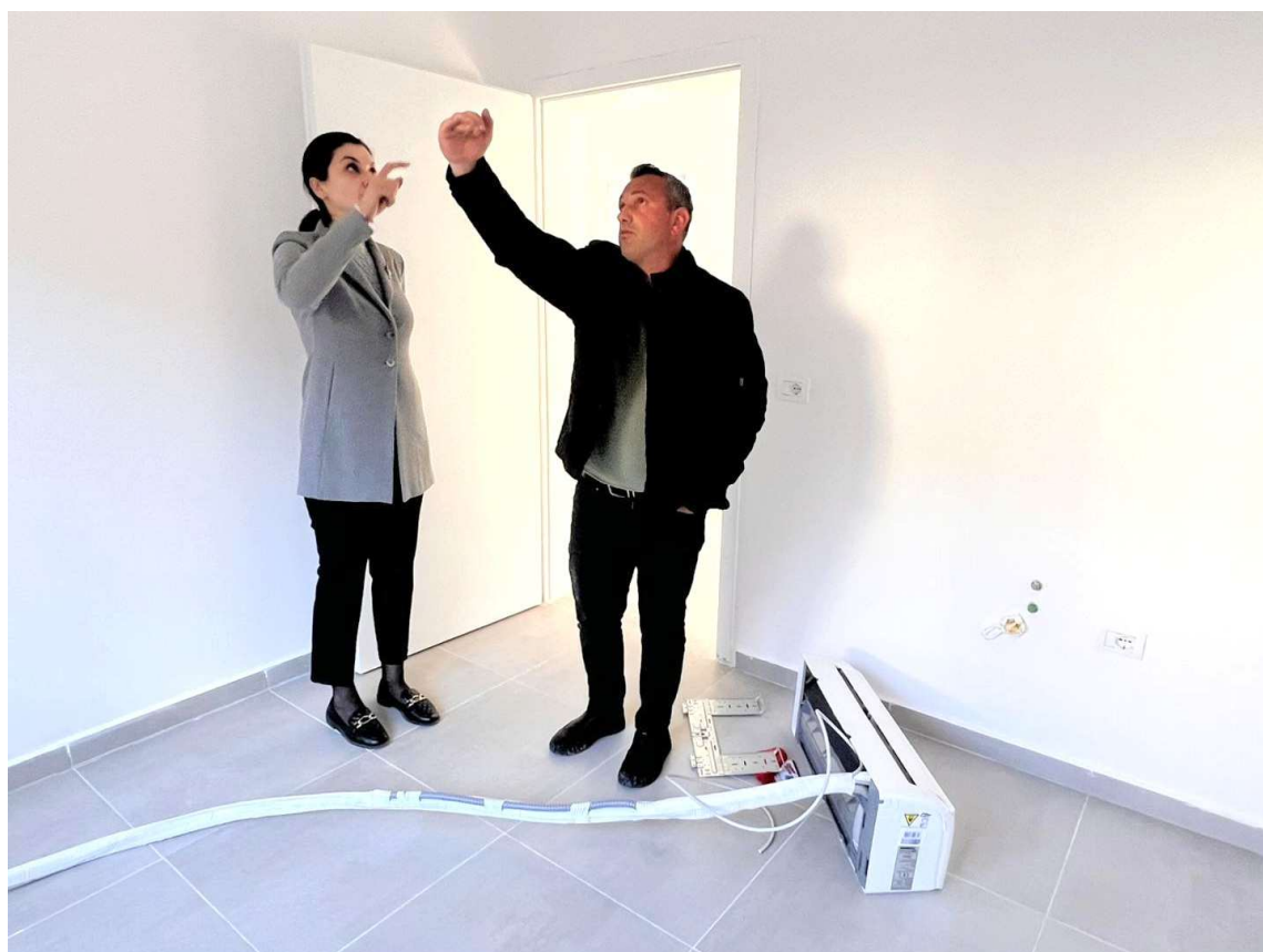
Diskussion über die Installation der Klimaanlage mit dem Administrator
