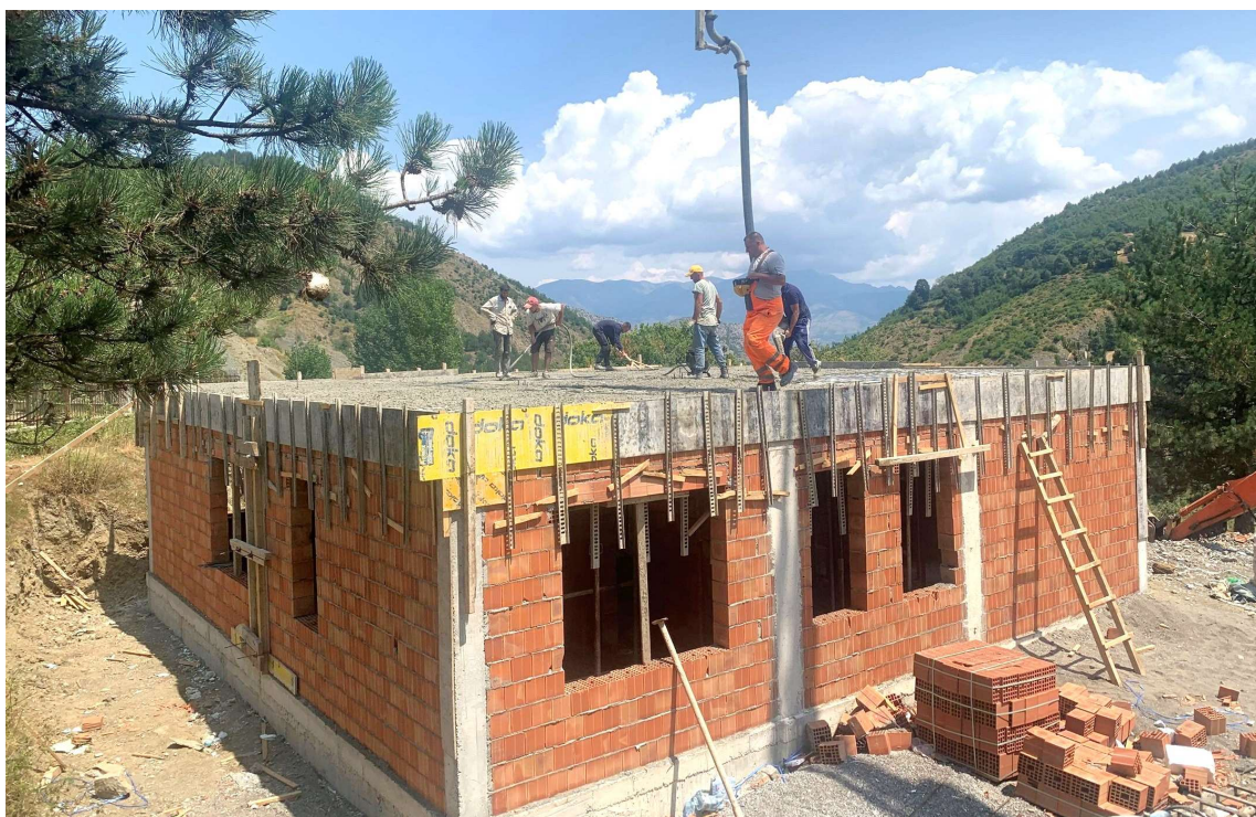
Das Betondach ist gemacht, noch fehlen die Dämmung und die Hydroisolation
