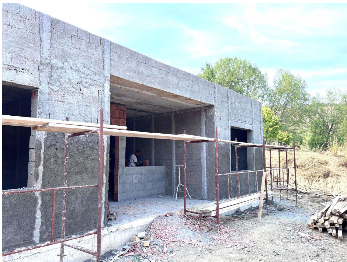
Die erste Schicht vom Aussenverputz ist aufgetragen
