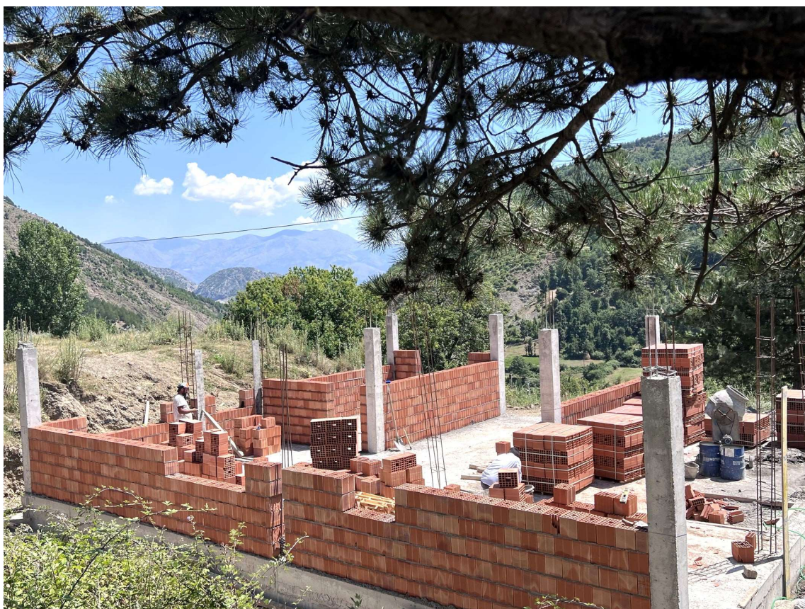
Im nächsten Schritt wurden die Mauern hochgezogen
