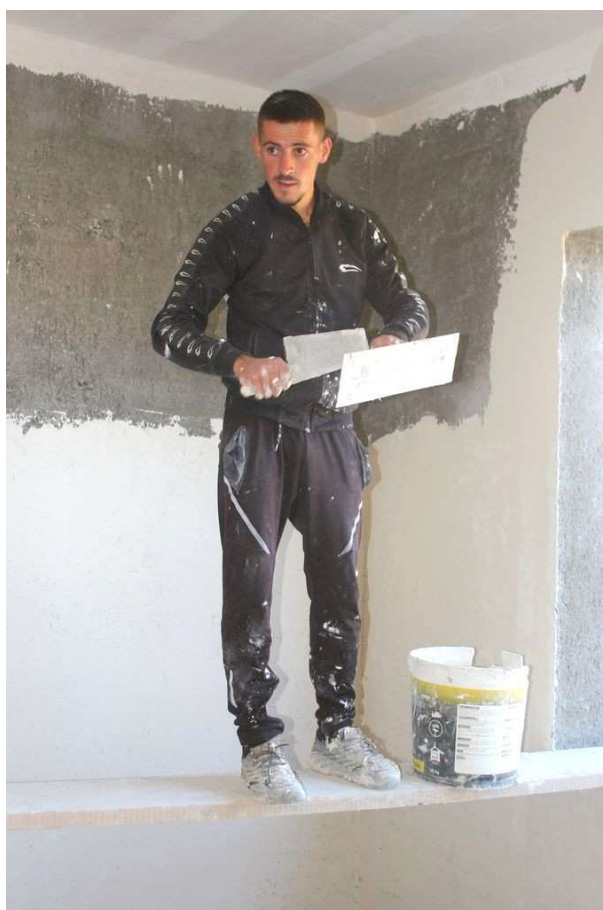
Ein Arbeiter trägt den Verputz innen auf
