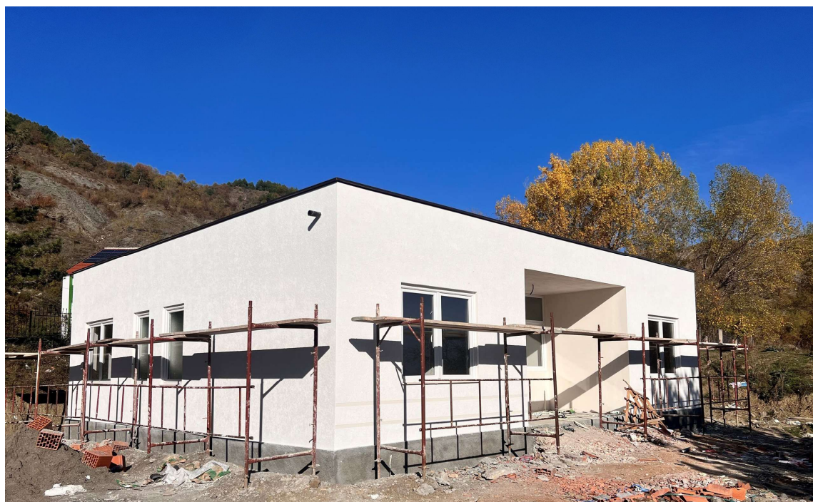
Zwei Monate später sind die Fenster eingesetzt. Der Winter kann kommen
