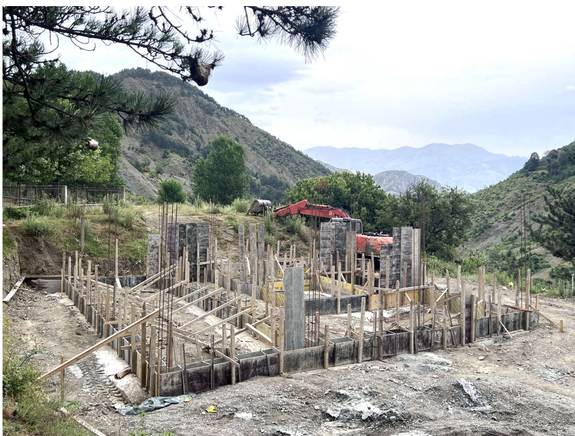
Die Arbeiten am Fundament haben begonnen
