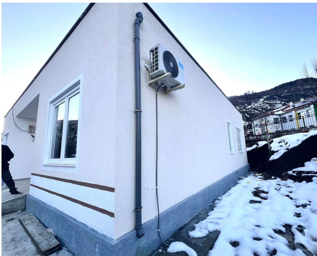
Der Winter ist da, die Abflussröhren vom Dach und die Klimaanlage sind montiert
