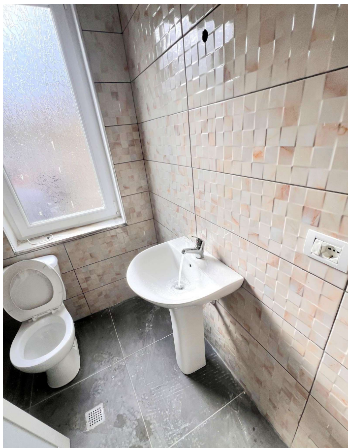
Die Toiletten sind fertig. Das Wasser läuft
