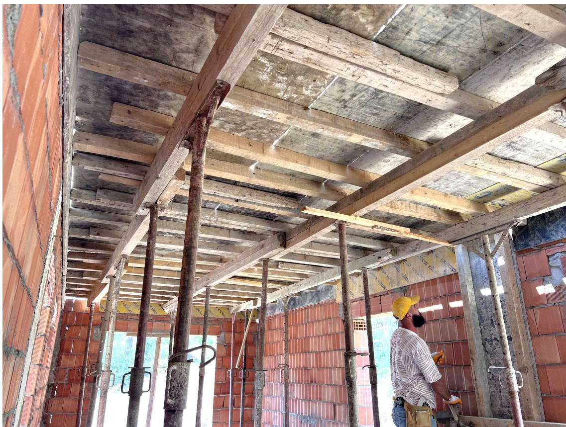
Im Inneren des Gebäudes während den Arbeiten
