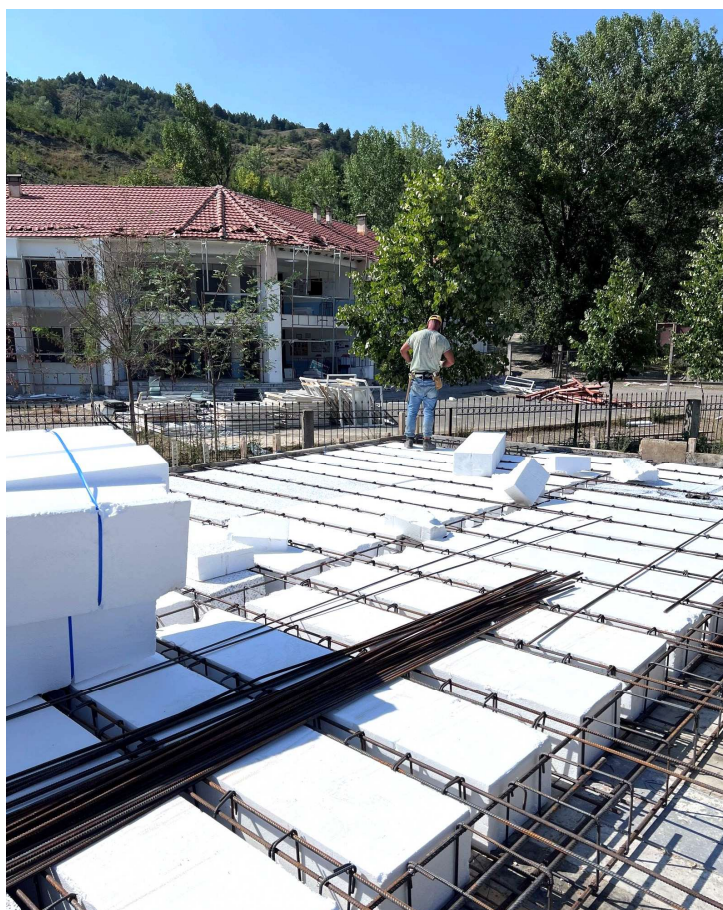
Installation der Dämmung
