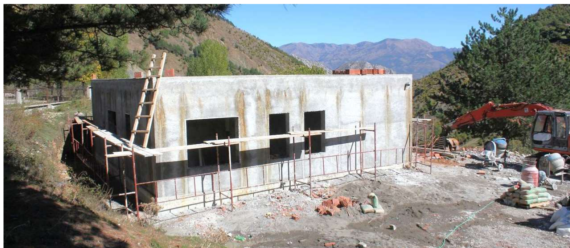
Das neue Gebäude nimmt Form an
