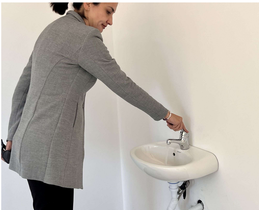
Kontrolle der sanitären Installationen
