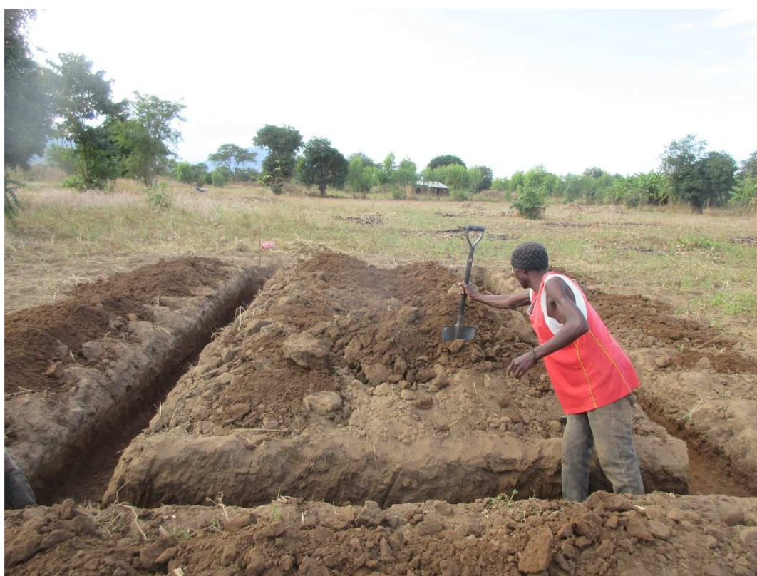
Das Fundament für den Wassertank wird vorbereitet
