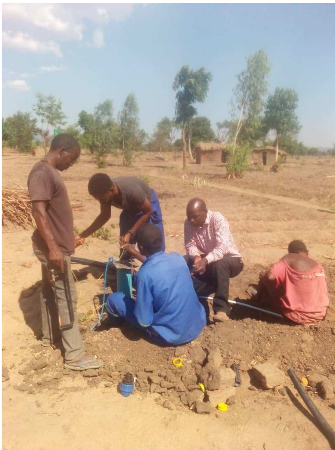
Einbau der neuen Pumpe für die ersten Tests
