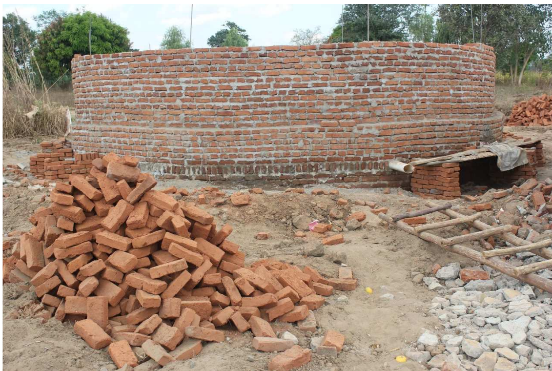
Der zweite Tank war schon fast fertig
