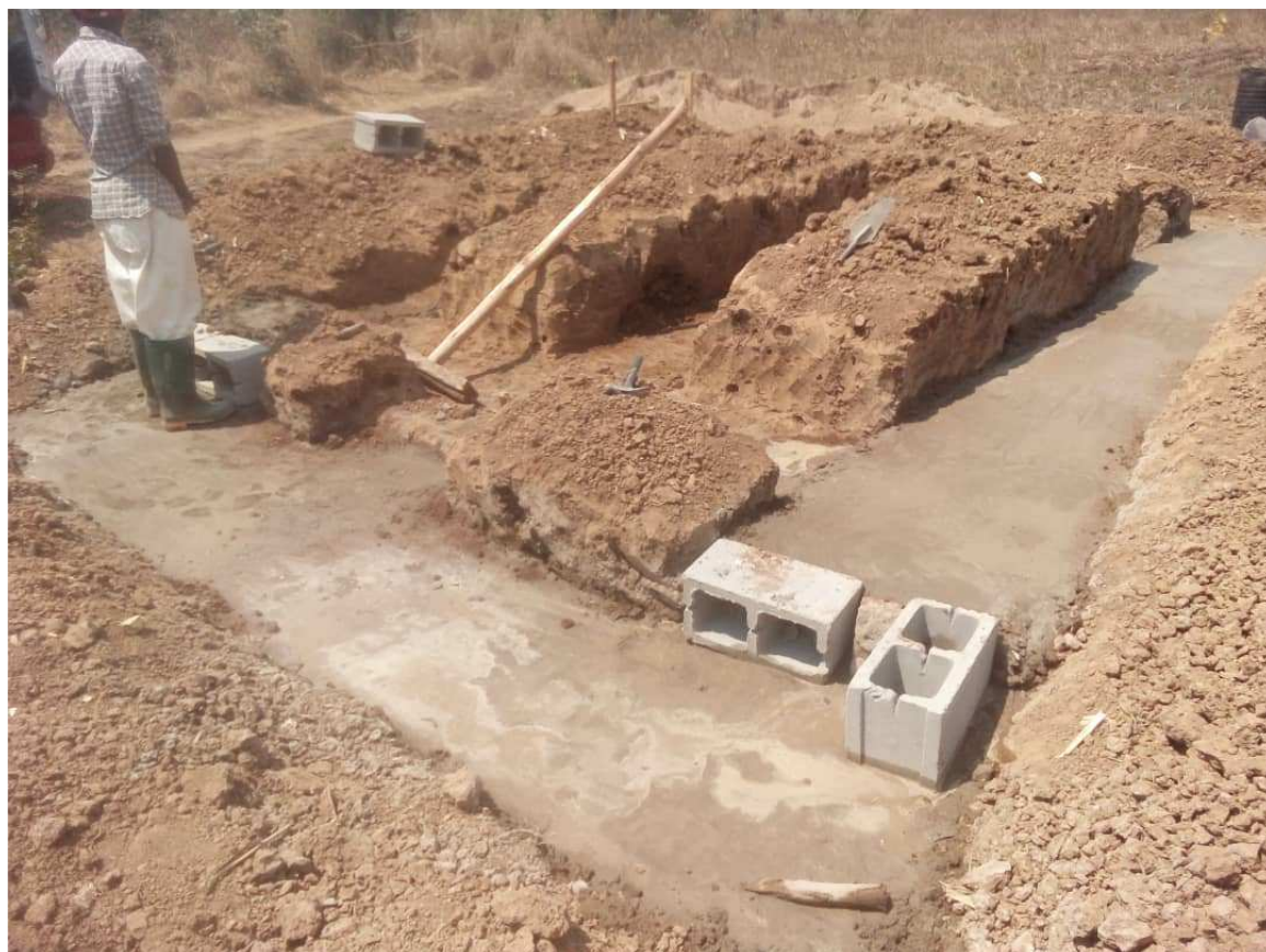
Neustart im September 2024. Fundament für den Aufbau, der die Tanks tragen sollte
