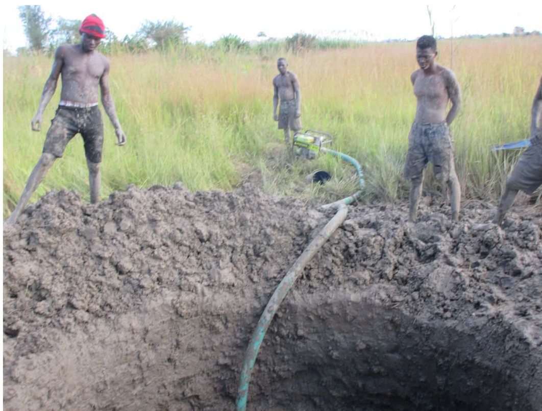
Aushub für einen der beiden Brunnen
