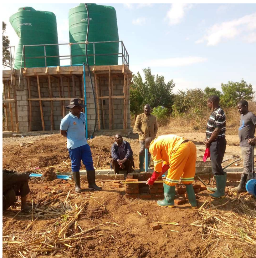
Die Tanks wurden geliefert, nun begann die Arbeit an den Hydranten
