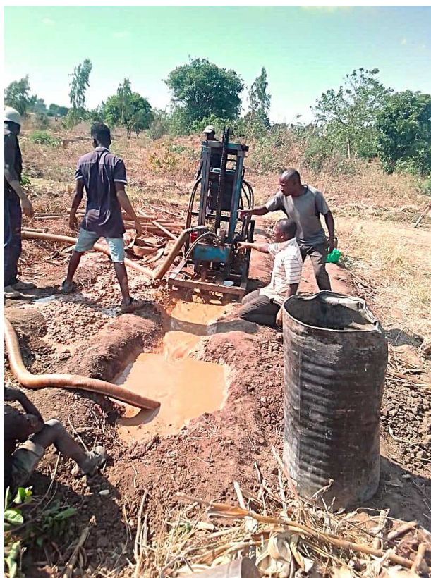
Die Bohrung für den neuen Brunnen
