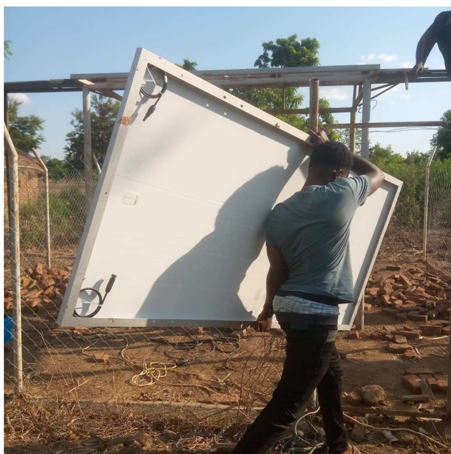
Montage der zusätzlichen Solarpanels
