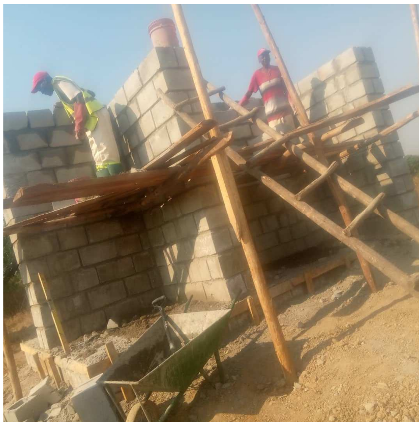
Das neue Konzept sah zwei Tanks auf einem Aufbau vor, der hier gebaut wird
