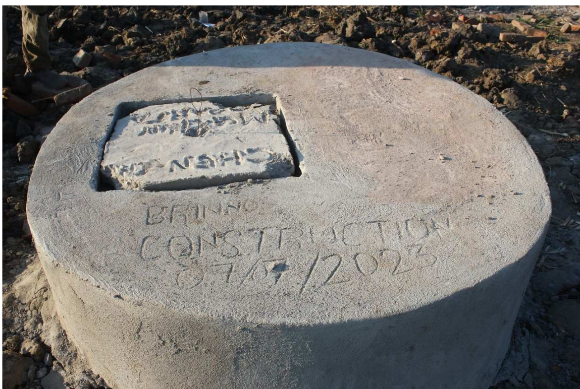
Einer der beiden Brunnen – eine Pumpe war gestohlen worden
